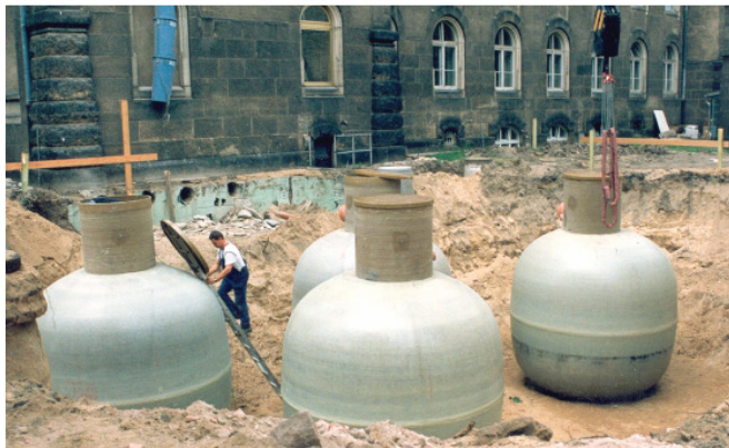
Abb.: Abklingbehälter werden vor der Klinik in den Boden gebracht.
